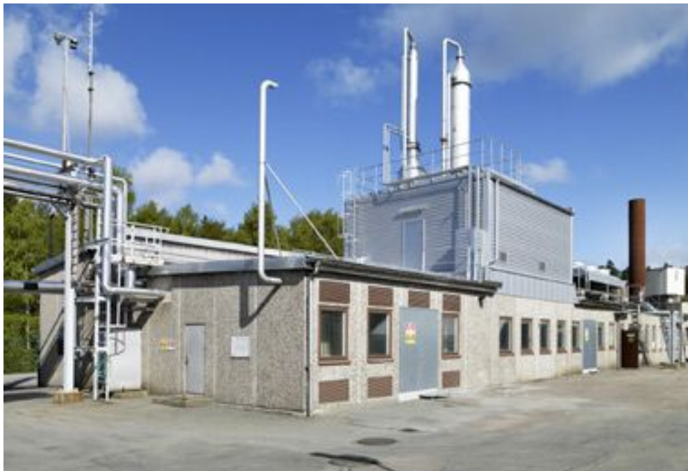
Bild 8: Uppgraderingsanläggning med kemisk absorption (COOAB) i Arendal, Göteborg (Bild från http://www.goteborgenergi.se )
