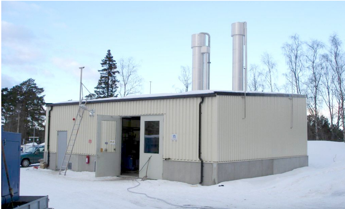
Bild 4: Uppgraderingsanläggning med vattenskrubbteknik vid Gövikens reningsverk i Östersund (Bild: BioMil AB)
